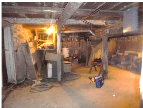
Photo 14 : Sous-sol, partie arrière sous la sacristie.
