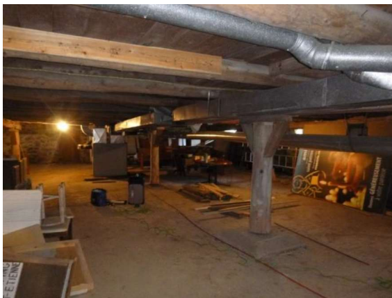
Photo 19 : Sous-sol, partie avant.
