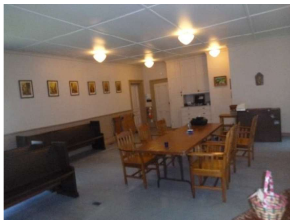
Photo 8 : 1 e étage, sacristie (partie arrière). Les surfaces visibles avaient une apparence saine.
