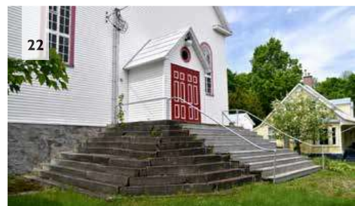
Vue du perron et du tambour de la façade avant de l'église
