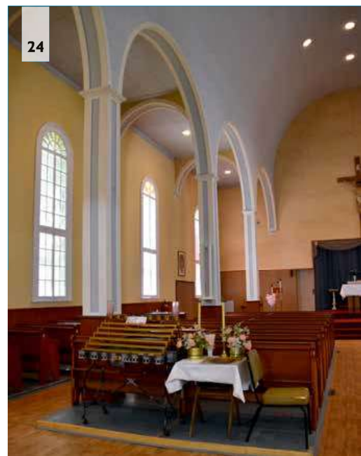
Vue partielle des colonnes à l'intérieur de la nef
